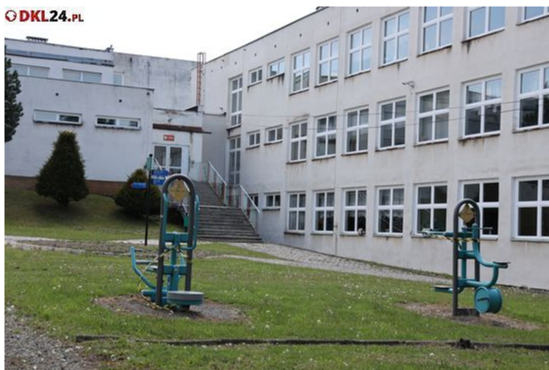
Na dachu tej szkoły powstanie panelowa elektrownia słoneczna
