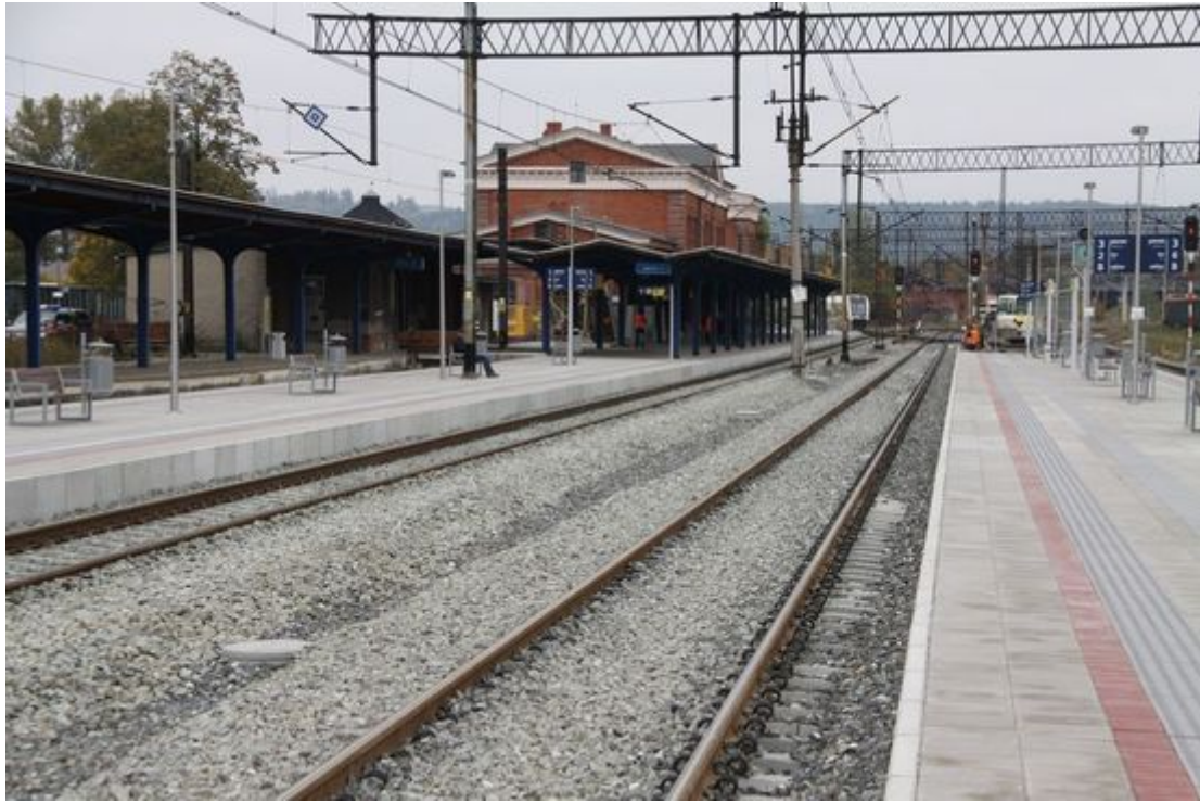
Przebudowany obszar stacji Kłodzko Główna
