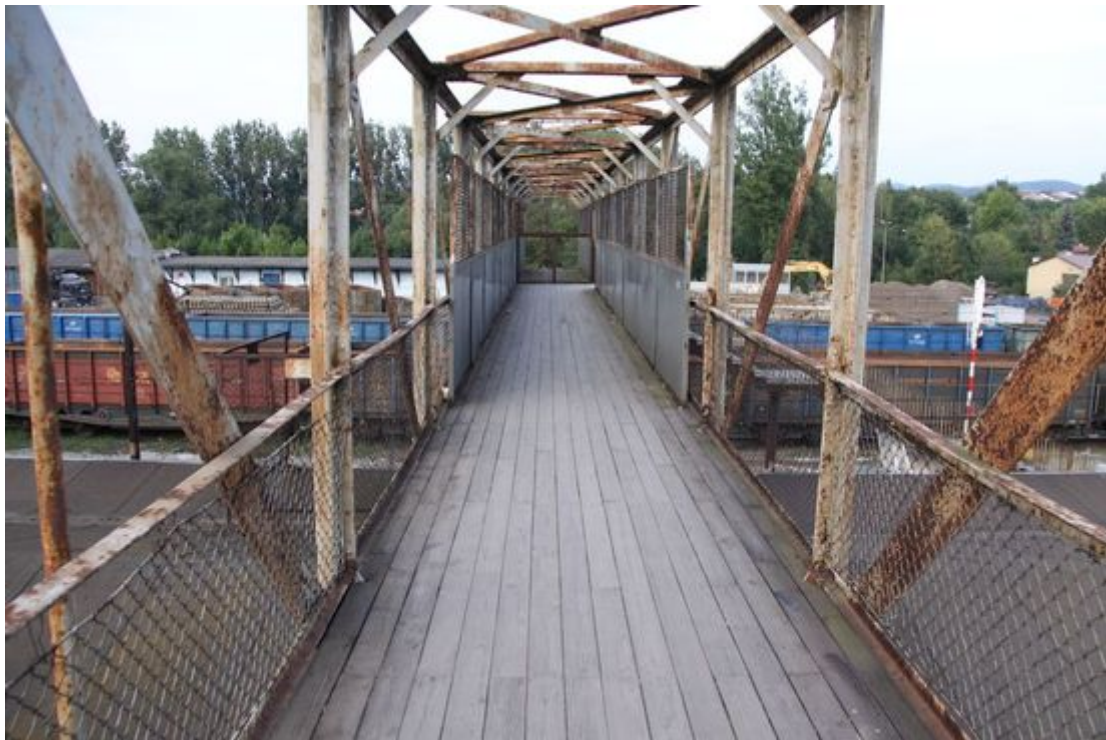
Kładka nadtorowa ułatwiła przejście nad stacją z ulicy na ulicę
