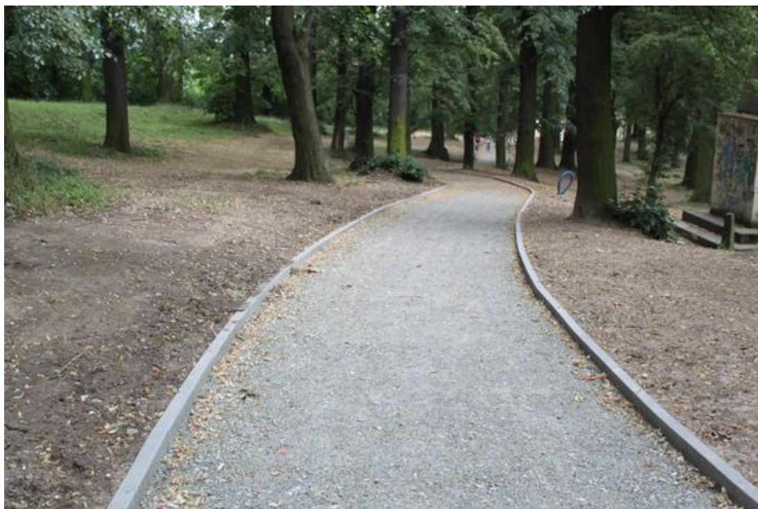
Budowana ścieżka rowerowa też przebiega między drzewami
