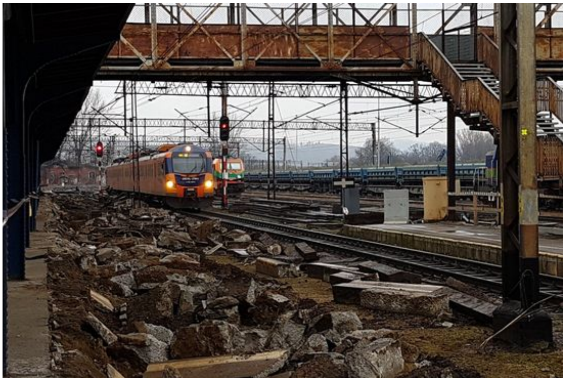
Tak było jeszcze niedawno na stacji Kłodzko Główne
