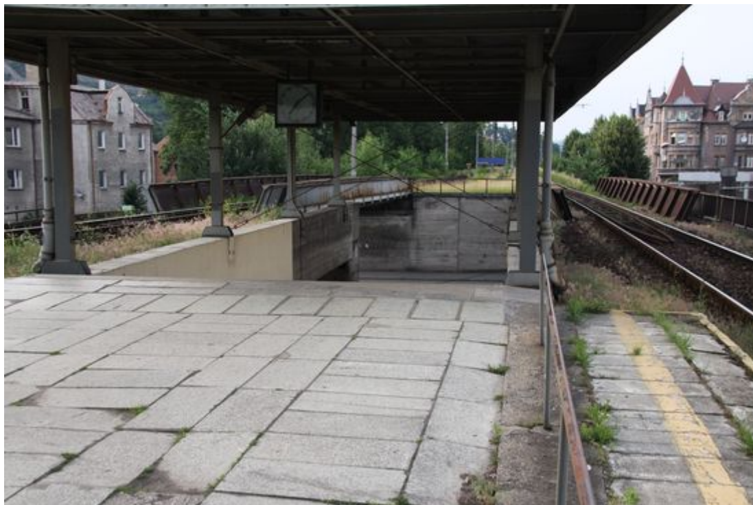
W połowie lat 70. XX stulecia przebudowano i tą część przystanku
