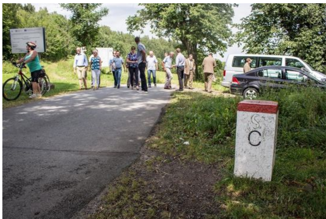
Przebudowana droga prowadzi do i z Czech
