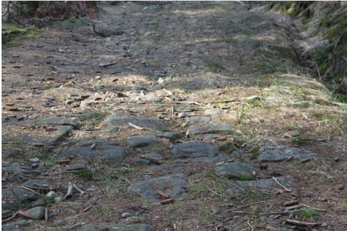
Leśne drogi w wielu miejscach są utwardzone pod duży transport
