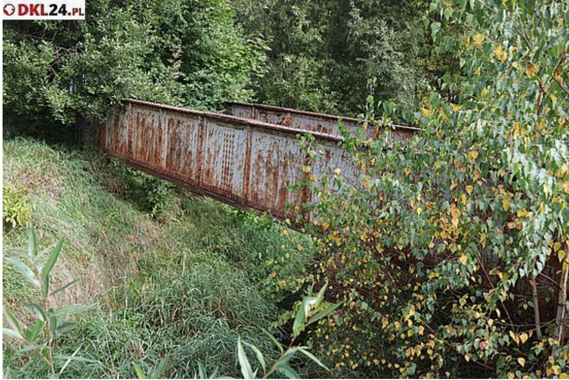
Samorząd województwa odbuduje linię kolejową i obiekty inżynieryjne na niej
