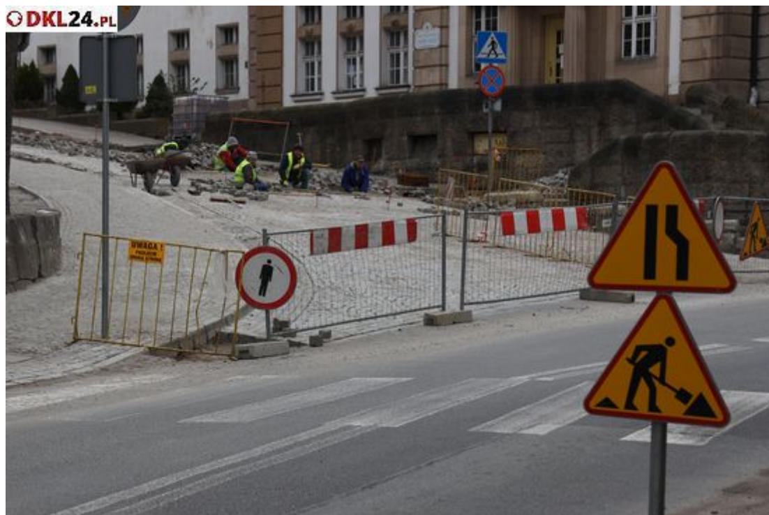
W Łądku-Zdroju przebudowano ul. Ostrowicza
